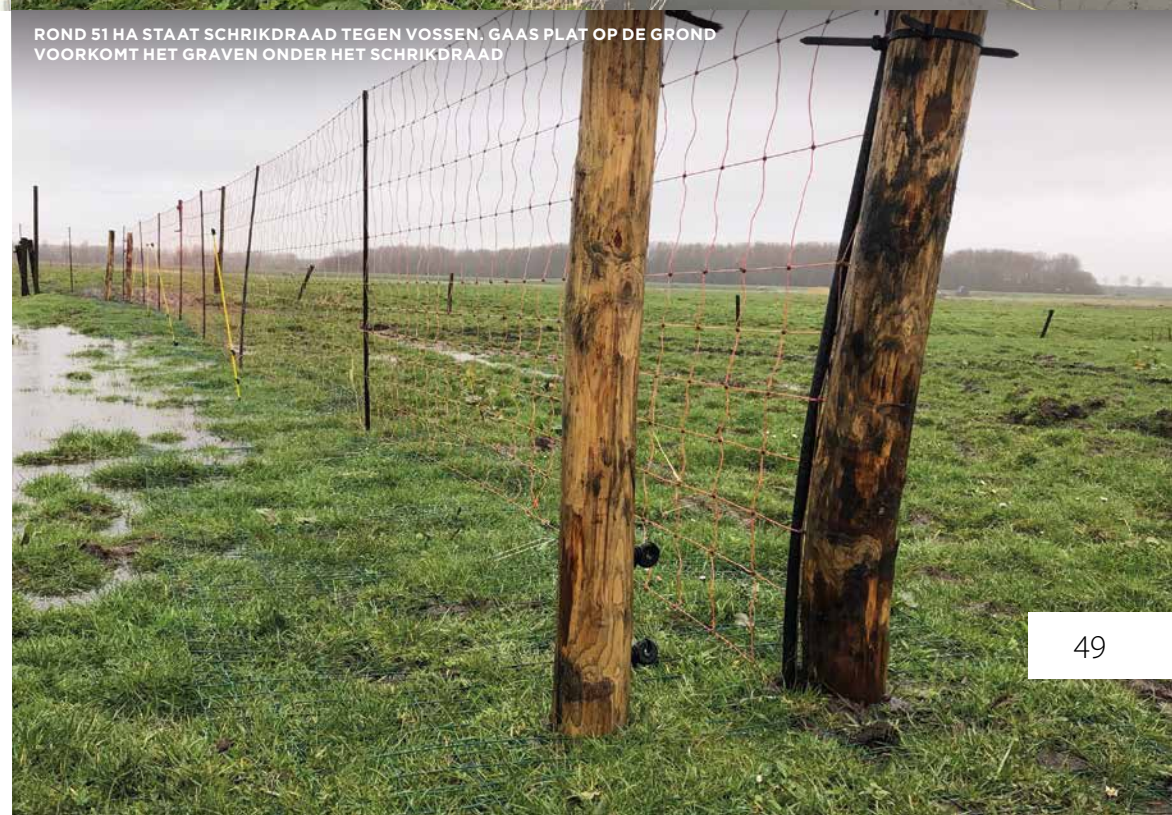
ALS HET KON, WERD HET VOSSENRASTER IN DE SLOOT GEPLAATST
